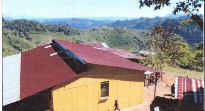
Foto 2: Se observa daño en las laminas del modulo 1
