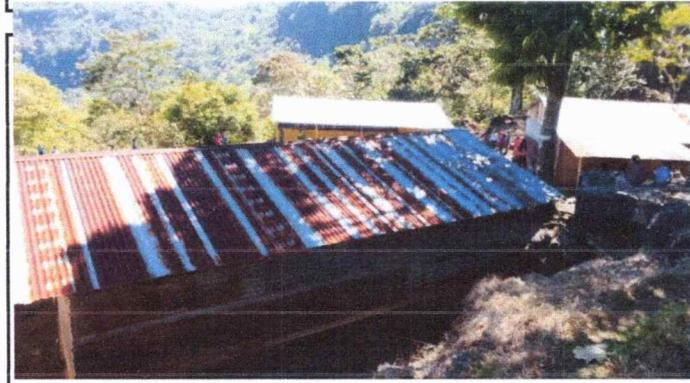
Foto 3: Se observa en mal estado las laminas de aulas
