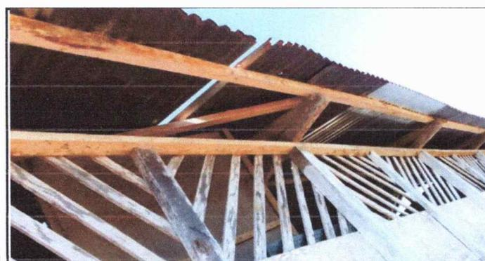
Foto 5: se onserva el odulo de cocina y bodega en mal estado las laminas
