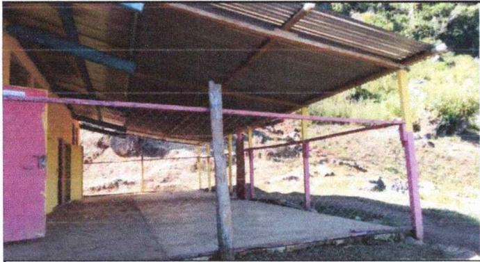
Foto 1: Se observa deterioro de malla de las costaneras laminas modulo 1
