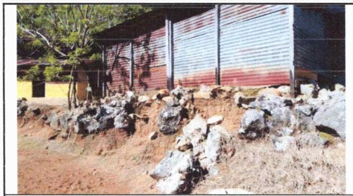
Foto 8: SE OBSERVA EL MODULO DE MURO EN MAL ESTADO
